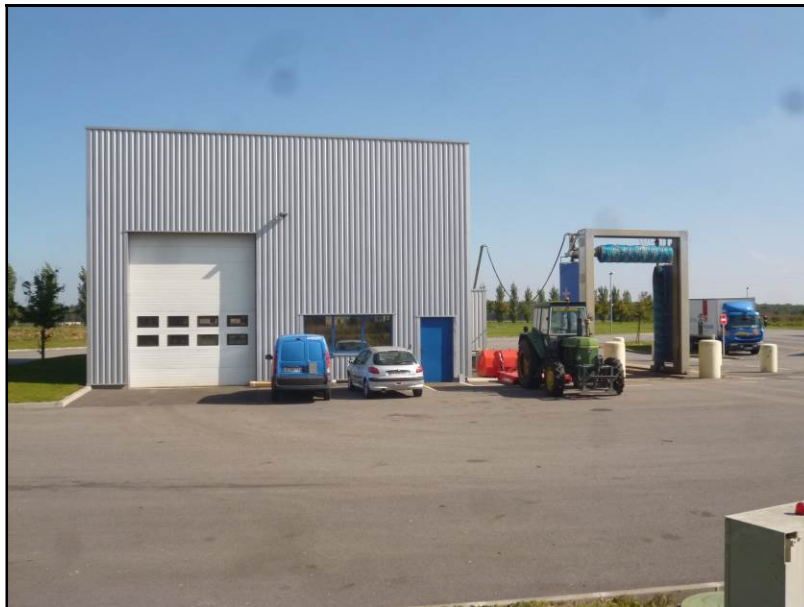
Garage Poids lourds et station de lavage
